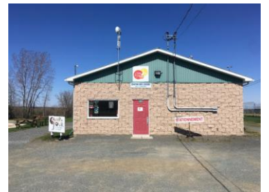
Vue avant du bâtiment
